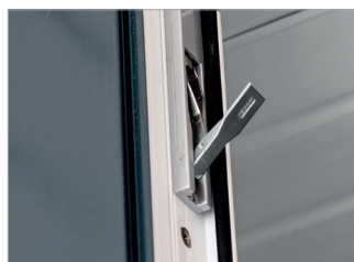
Zápustné čepy k zajištění neaktivního křídla (nahore a dole)
